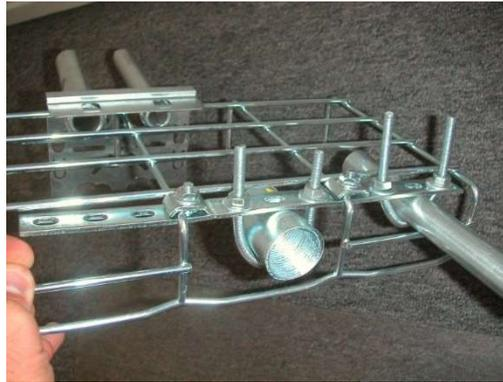
Toda terminación de tubería conduit, ya sea en cajas o en plafón, aparente u oculta, deberá estar rematada, en sus extremos, con los accesorios denominados “monitores”, para que se impida el daño del cable que conduce por fillos propios de la tubería.
