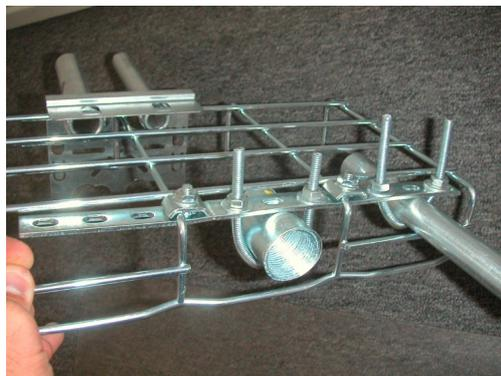
Los servicios de voz y datos de los pisos sótano, planta baja, piso 1 y 2 se alimentarán desde el rack del piso 3, para lo cual se utilizará una charola CABLOFIL CF54/200 o similar en características y calidad, la cual partirá desde el rack de comunicaciones en cada piso y se distribuirá conforme se ejemplifica en los planos anexos. Para la unión y la soportería de esta canalización se utilizará los mismos sistemas de unión rápida y de soportería que se describen a lo largo de este documento.
